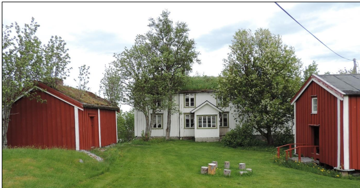
Våningshus, masstu og stabbur på bygdatunet i Osen.
